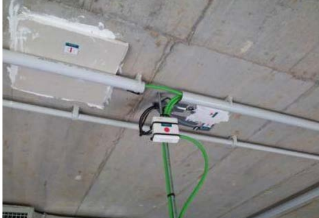
Figura 2. Sensores de temperatura y flujo térmico
