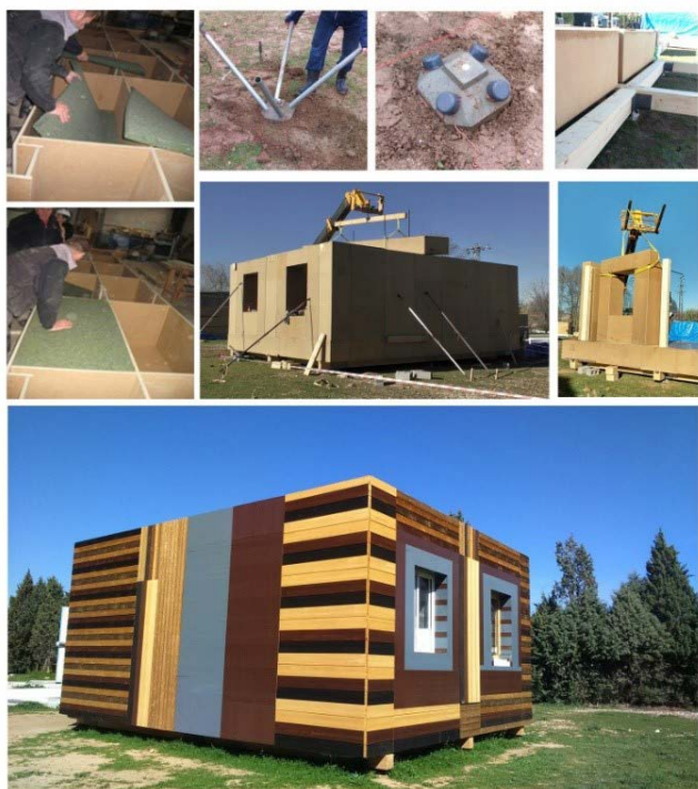
Fig. 6. Fotografías de diferentes etapas de la construcción del Laboratorio REVEN.
