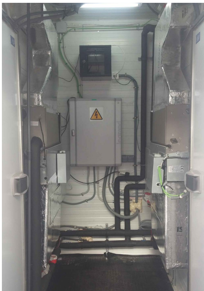
Figura 4. Localización de los sistemas de control, equipamiento de medidas y sistema de climatización en la cámara neutra.
