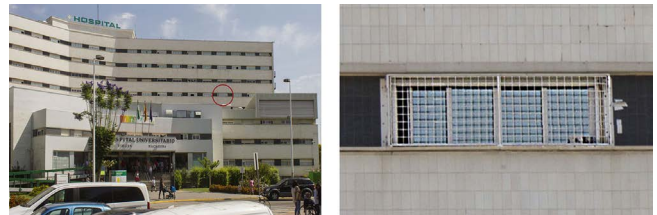
Figura 7. Edificio hospitalario (izquierda) y celosía de protección solar instalada (derecha) localización de los sensores y elementos de protección solar.
