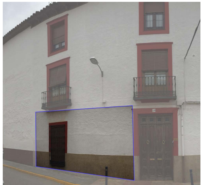
Figura 6. Ubicación del muro objeto de estudio en el edificio
