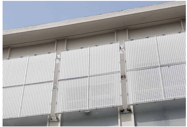
Figura 6. Celosía de protección solar en el edificio educativo.
