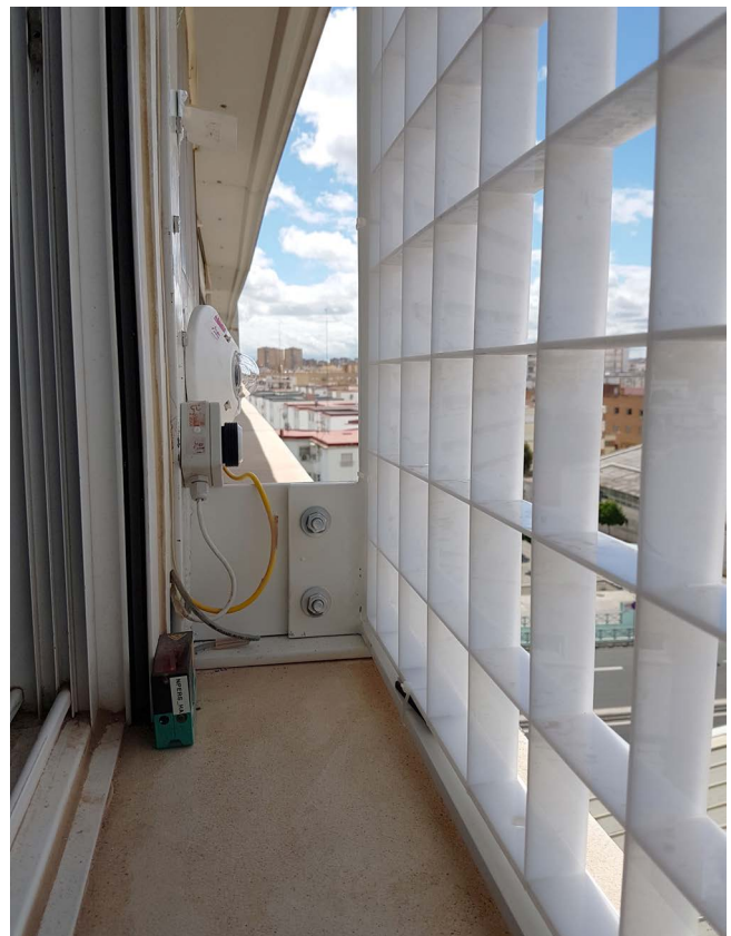
Figura 8. Localización del pirgeómetro y piranómetro detrás de la celosía de protección solar en el edificio hospitalario.
