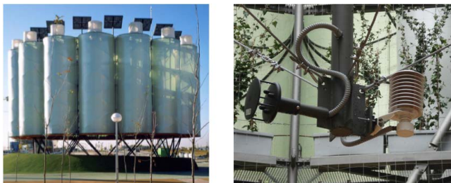
Figura 6. Árbol Evaporativo y detalle de la monitorización
