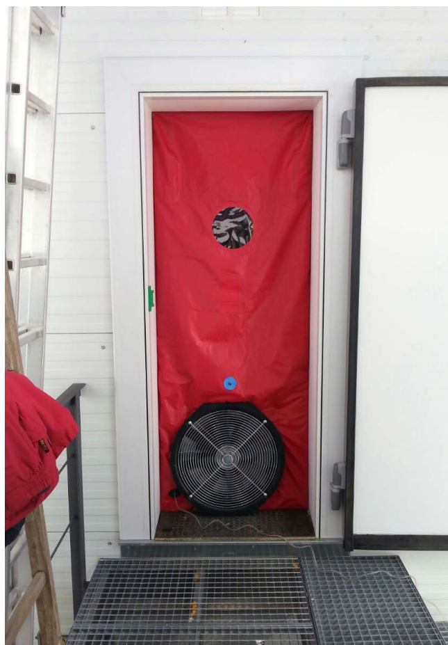
Figura 5. Realización del ensayo Blower Door
