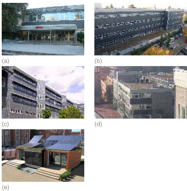
Figura 2. (a) Edificio A, (b) Edificio B, (c) Edificio C, (d) Edificio D y (e) la vivienda solar autosuficiente MagicBox de la ETSIT-UPM.
