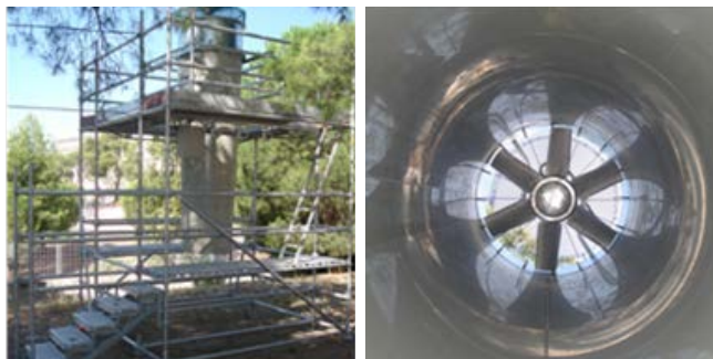
Figura 5 Instalación de torre de viento evaporativa en el CIEMAT
