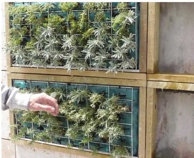
Figura 3. Esquema de sistema de jardín vertical
